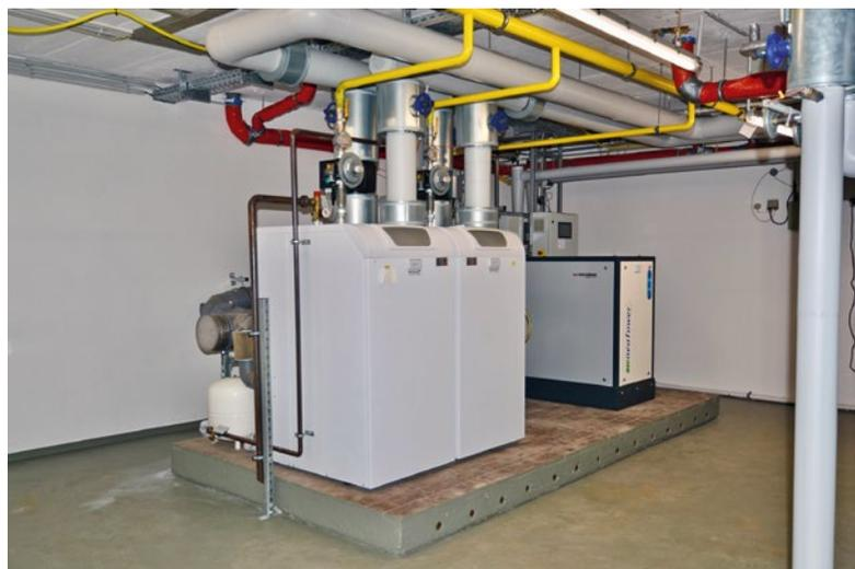
◀ Die zwei Gas-Brennwertkessel tragen die Hauptlast der Wärmeerzeugung, das BHKW im Hintergrund deckt die Grundlast an Wärme und Strom.
